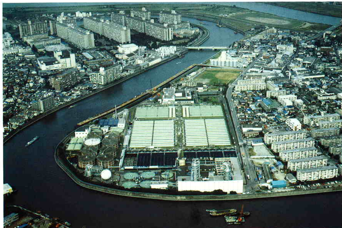
下水処理場の全景
