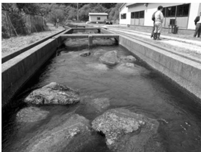
図V-13 サクラマスふ化場内の人工河川（3m×130m）
